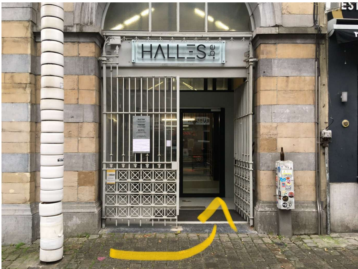
Dit is de hoofdingang van de Hallen van Schaarbeek
